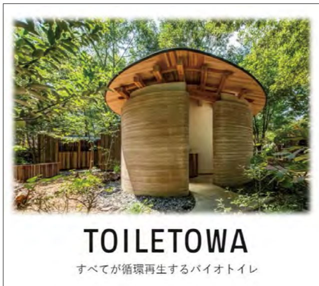
壁はリサイクル資材で施工。「循環と再生」を体現
